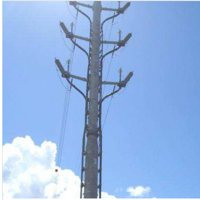
Figura 4. Configuración convencional de transición aéreo-subterránea, con los cables de potencia instalados exteriormente sobre la estructura.
